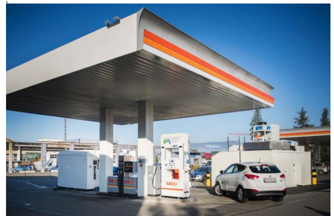
Bild: Wasserstofftankstelle Hunzenschwil
